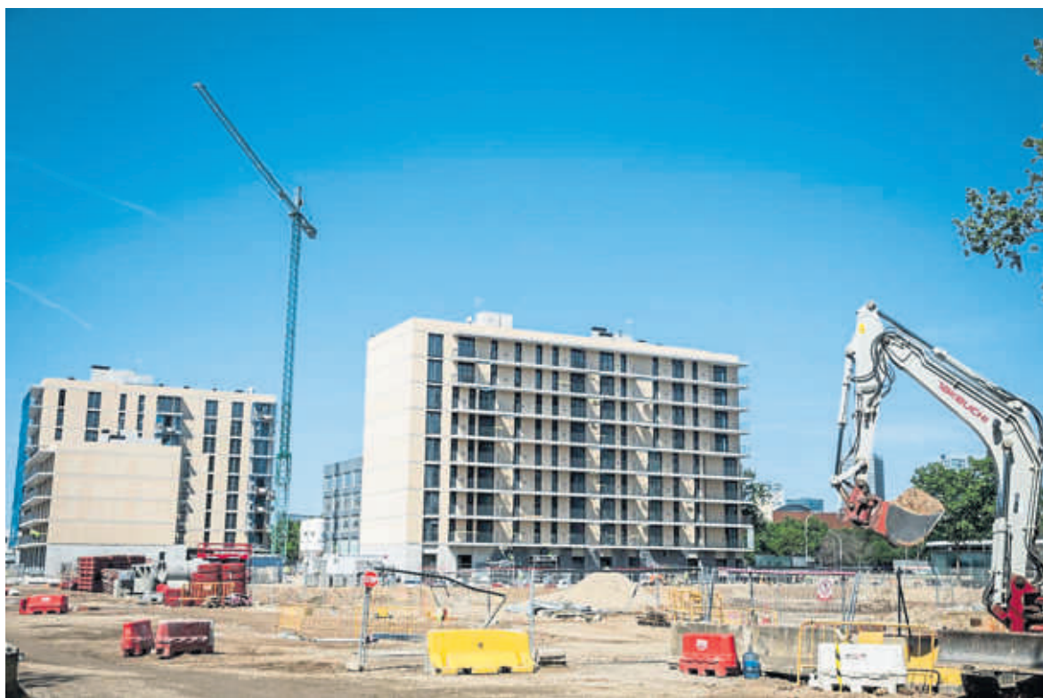
Viviendas en construcción en el barrio barcelonés de la Marina del Prat Vermell
